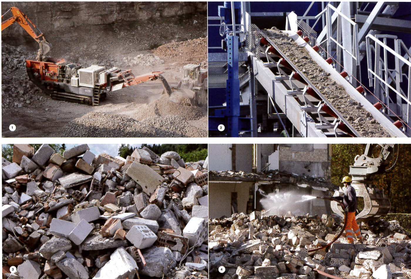
1+2: Arbeitsmaschinen für Rückbau und Recycling haben sich rasant entwickelt – erhalten mit entsprechend ausgebildetem Fachpersonal ihren wirtschaftlichen und zuverlässigen Einsatz (Prallbrecher/Urs Peyer).
